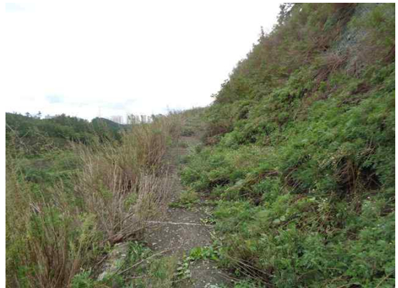
2소단 배수로 전경
