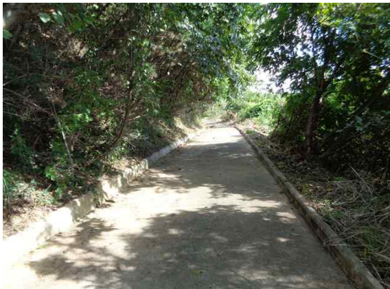
1소단 배수로 전경
