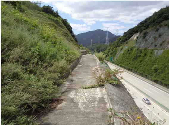
1소단 배수로 전경
