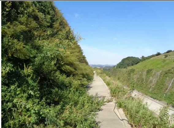
1소단 배수로 전경
