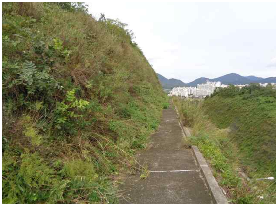
1소단 배수로 전경
