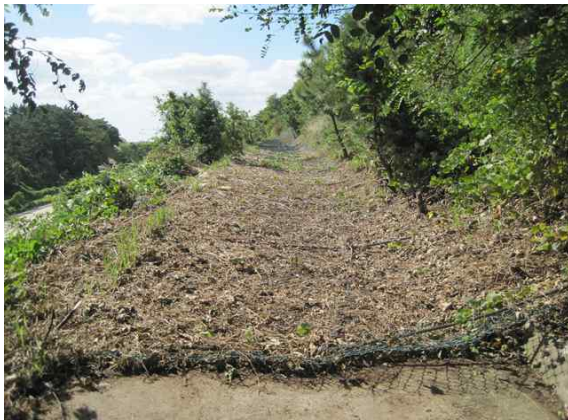
1소단 배수로 전경
