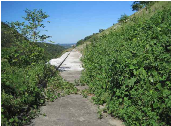
1소단 배수로 전경
