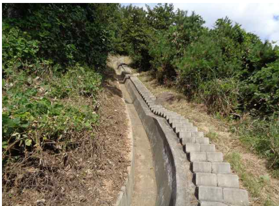
산마루측구, 점검계단 전경
