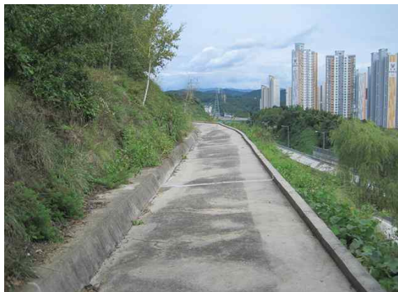
1소단 배수로 전경
