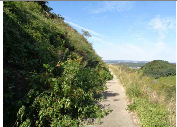
2소단 배수로 전경
