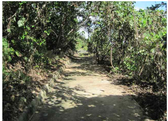
2소단 배수로 전경
