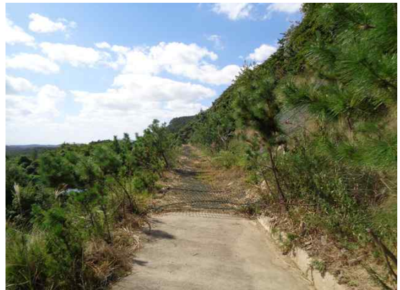
2소단 배수로 전경
