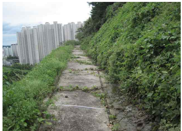
2소단 배수로 전경
