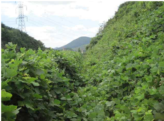
1소단 배수로 전경
