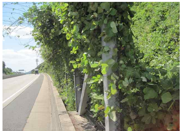
하부, 낙석방지울타리 전경
