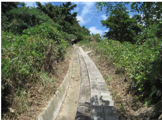
산마루측구, 점검계단 전경
