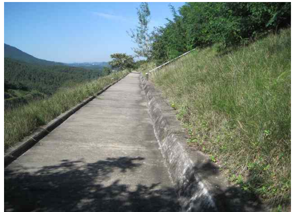
2소단 배수로 전경
